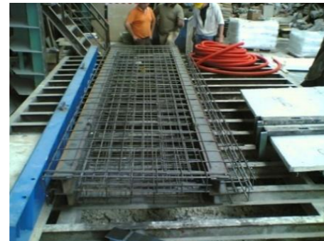
Nouvelles dalles (moins lourdes)
