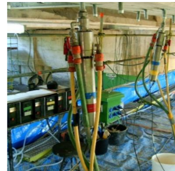
Injection d'inhibiteur de corrosion : Pompe à ultrasons de puissance en action
