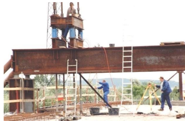
Vérinage prenant appui sur les culées (après soulèvement de 3 m)
