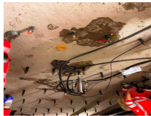
Sonotrode à ultrasons de puissance pour injection d'inhibiteur de corrosion
