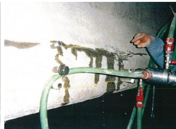
Injection d'inhibiteur de corrosion : Pompe à ultrasons de puissance en action
