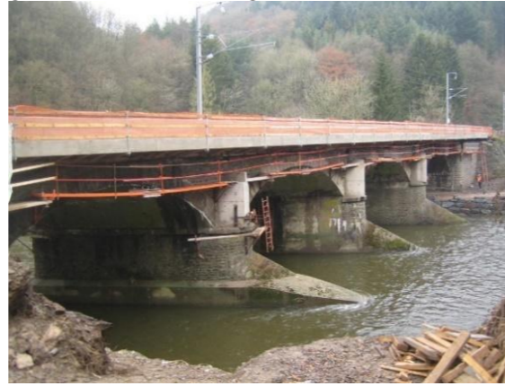
4 -Nouveau tablier en place après
