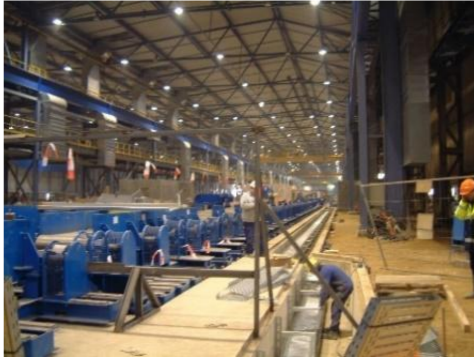
Laminoir en cours de montage
