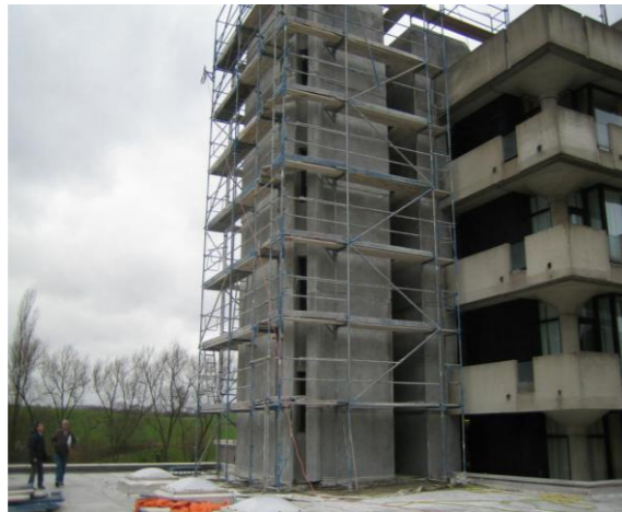
Vue du chantier
