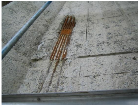
État de surface du béton
