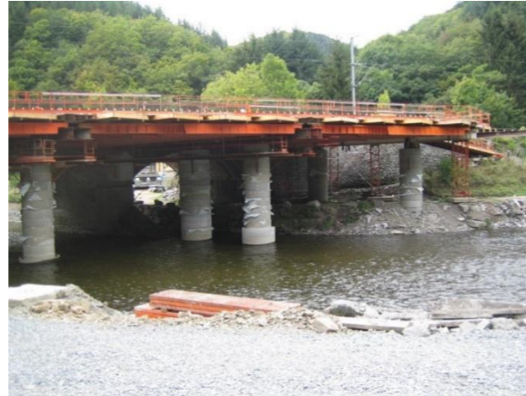
2 -Plateforme pour bétonnage du nouveau tablier avec rails de glissement pour ripage
