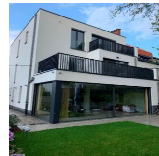
Façade arrière après travaux
