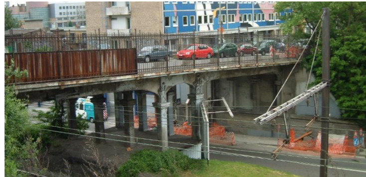
Vue du pont
