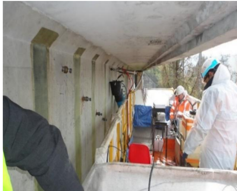
Sonotrode à ultrasons de puissance pour injection d'inhibiteurs de corrosion
