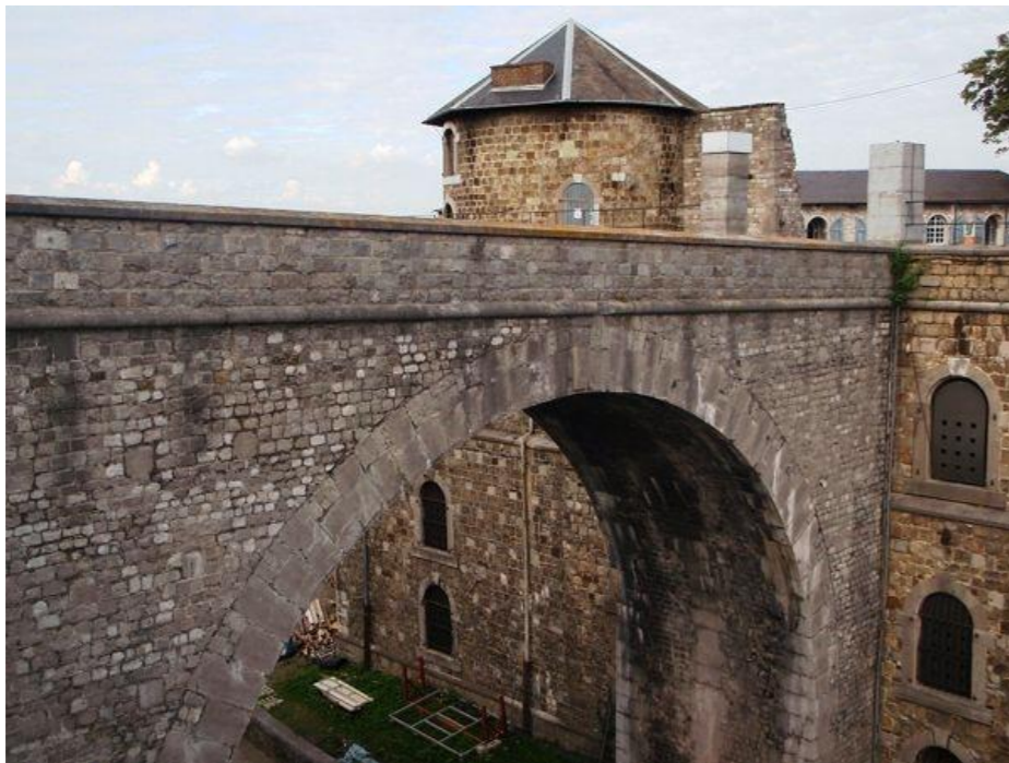
Avant travaux façade
