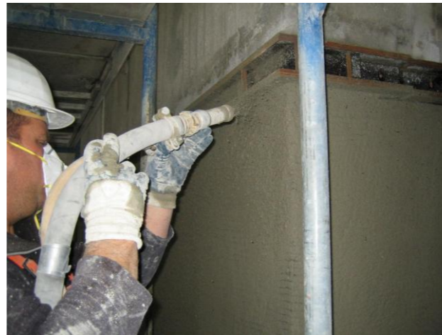
Projection de béton
