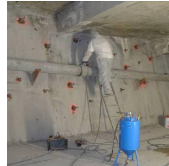
Réinjection de micro-coulis de ciment dans le caisson
