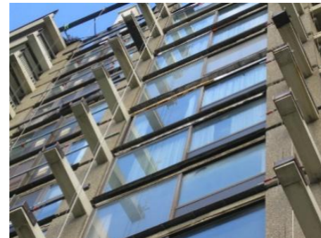
Enlèvement des anciennes dalles de balcons avec excès de chlorures
