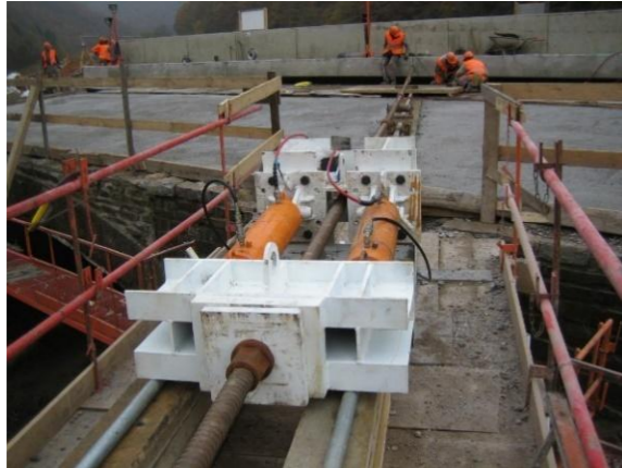
3 – Système de vérinage avec barres de traction Dywidag pour ripage
