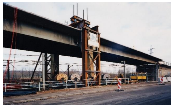
Portique de soulèvement central (Avant soulèvement)
