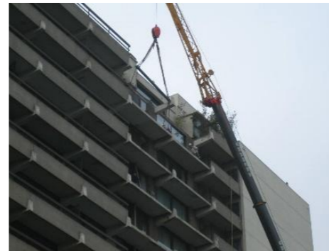
Nouvelles dalles en cours de mise en place
