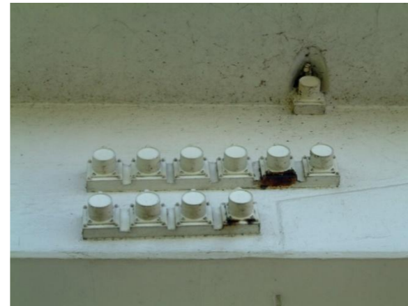
Précontrainte transversale des abouts
