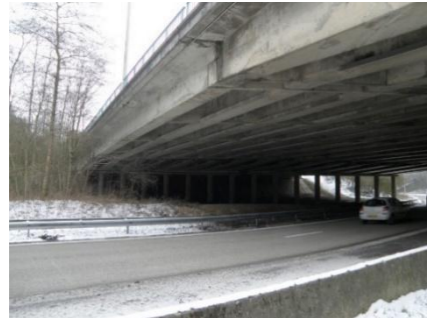
Viaduc de Courcelles
