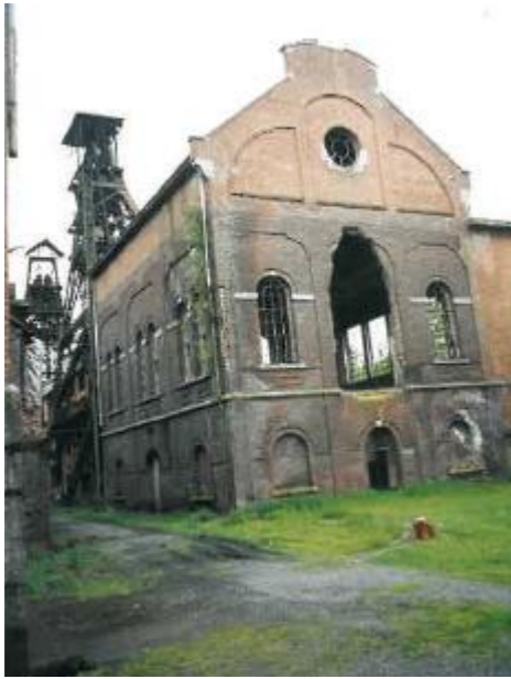
Avant travaux des façade
