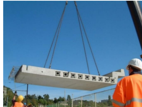
Un élément préfabriqué du nouveau tablier
