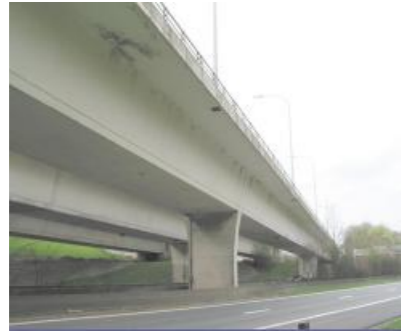
Viaducs de Courrière
