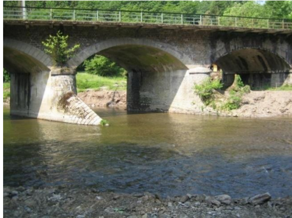
1 -Pont avant réhabilitation
