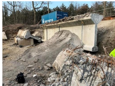
La poutre a été sectionnée en trois sections dont la section centrale
