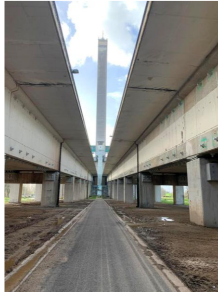
Vue inférieure entre les deux chemins de roulement inclinés
