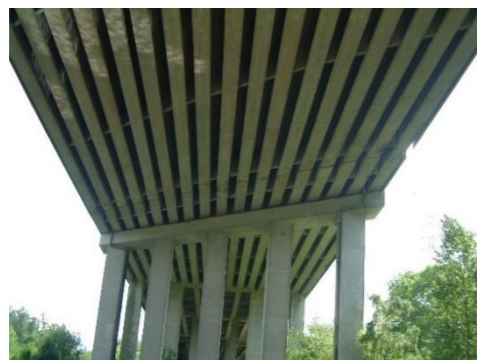
Vue sous le viaduc de Landelies
