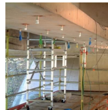
Sonotrode à ultrasons de puissance pour injection d'inhibiteurs de corrosion
