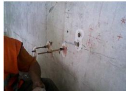
Travaux d'inhibition de la corrosion de câbles de précontrainte
