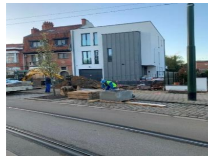
Façade avant après travaux
