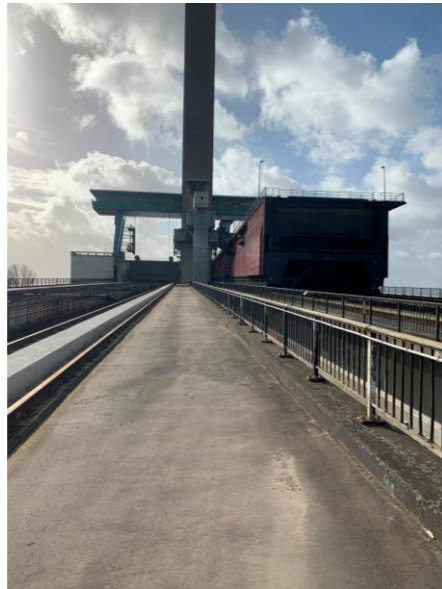
Vue supérieure des deux chemins de roulement inclinés des bacs contenant l'eau et les péniches de 1350 T
