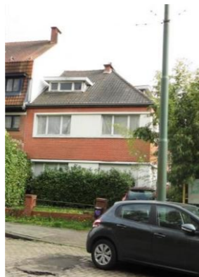
Façade avant avant travaux
