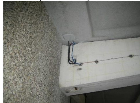
Blocage du processus de corrosion par protection cathodique
