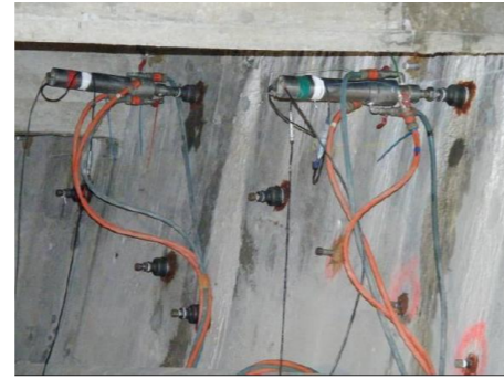
Sonotrode à ultrasons de puissance pour injection d'inhibiteurs de corrosion
